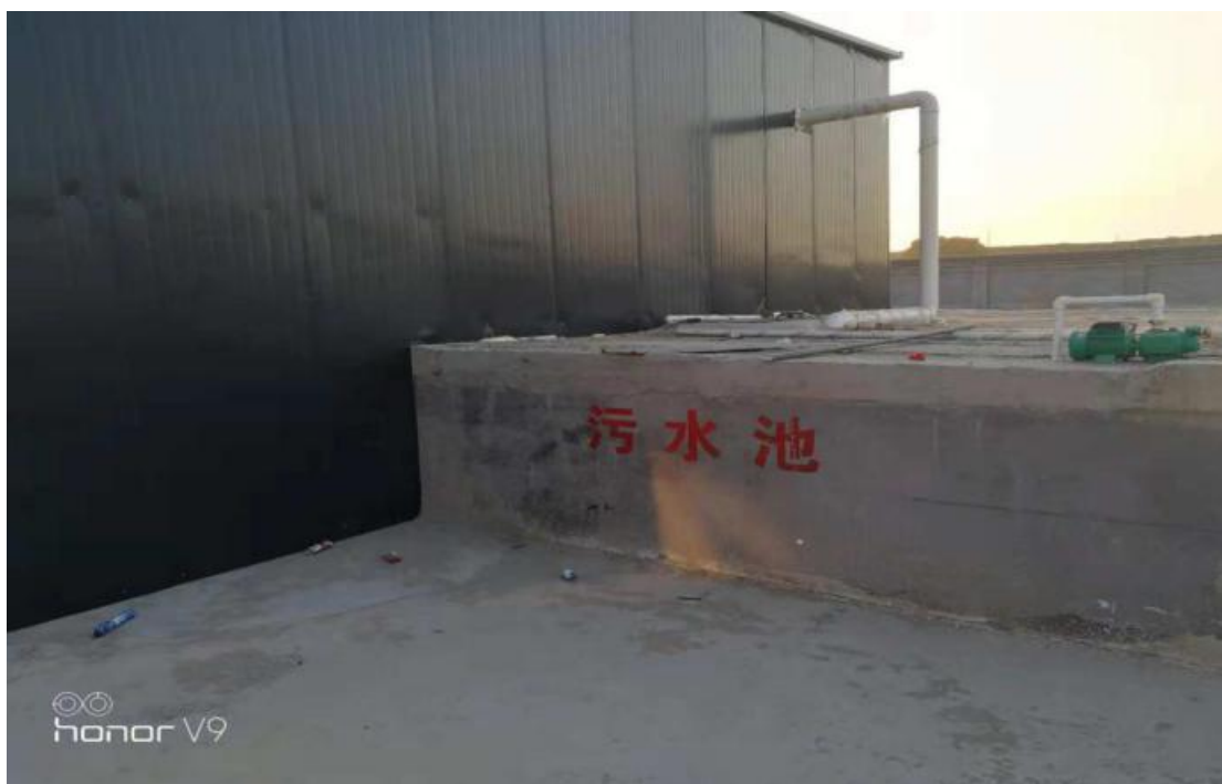
污水处理站污水池
