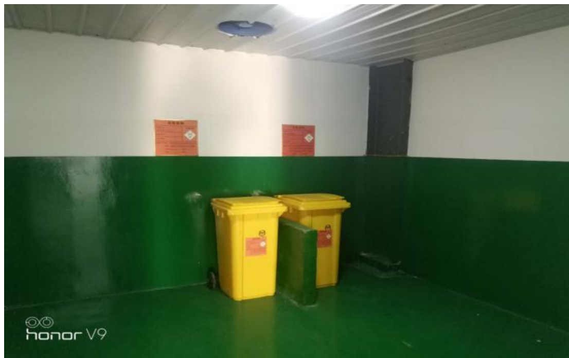
危废暂存间内部及危废暂存间废气收集孔
